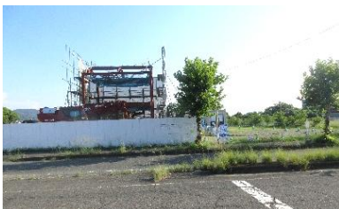
建設中の桜が丘交番
