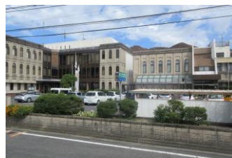
移設解体される 熊山支所と 熊山公民館
