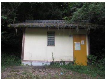
使用禁止のトイレ
